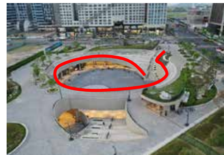
PLAZA CENTRAL MAGOK (SOCAVACIÓN).
