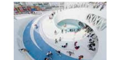
Circulaciones internas (Rampas).
