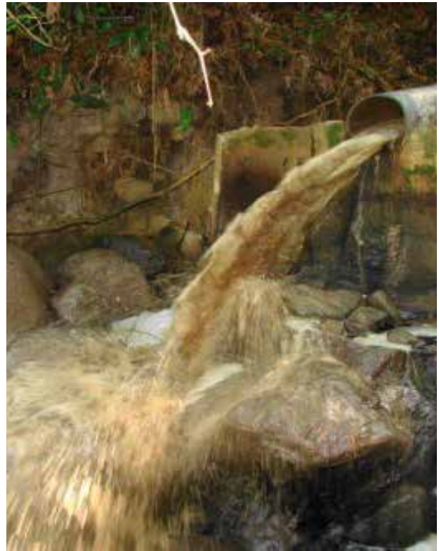
Figura 2. Derramamientos de aguas fétidas en el río Otún (rellenosanitariolaglorita.wordpress.com/)
