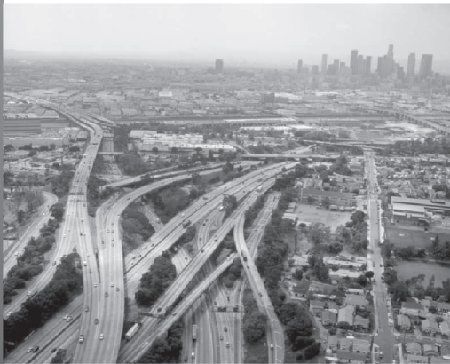
Figura 5. Panorámica complejo sistema de puentes elevados en los Ángeles. Fuente: Imagen editada por Diana Carolina Vargas a partir de fotografía tomada de http://www.privateangelestours.com/wp-content/uploads/2010/06/la-sky.jpg .
